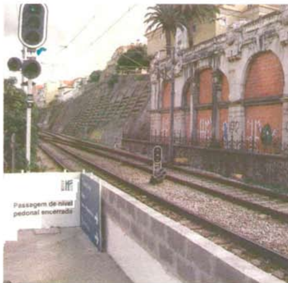
Passagem de nível para peões foi eliminada há quase duas semanas
