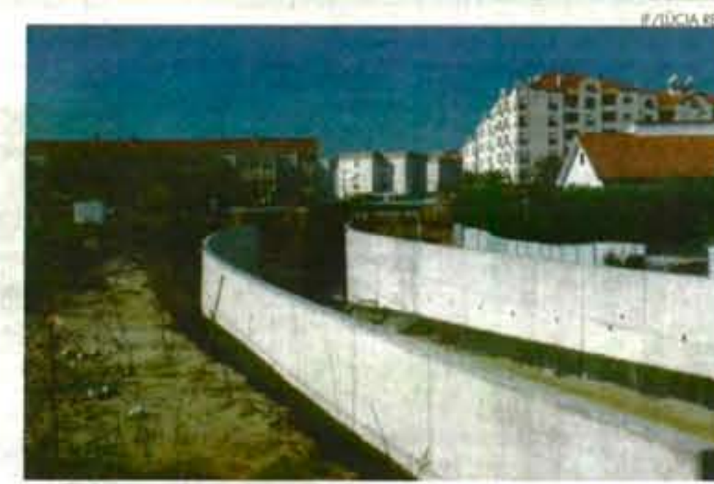
Túnel subterrâneo atravessa Rua Cidade da Covilhã até à Av.º Eugénio de Andrade
